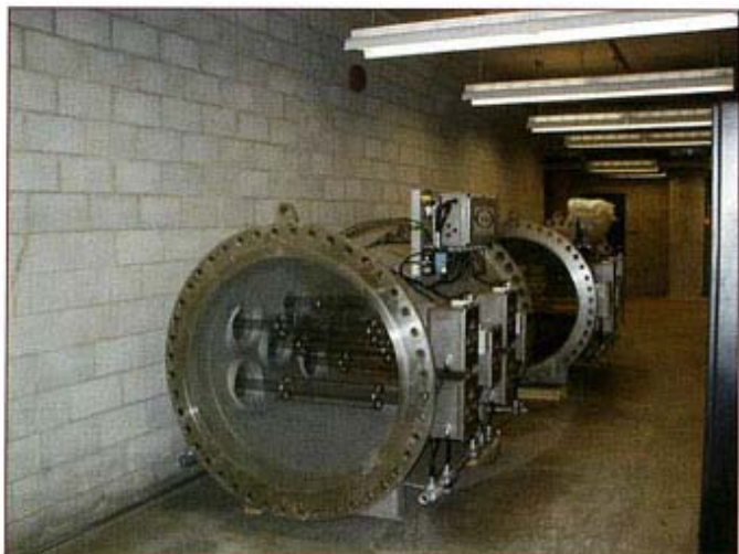
Рис. 2. Общий вид реактора перед установкой
